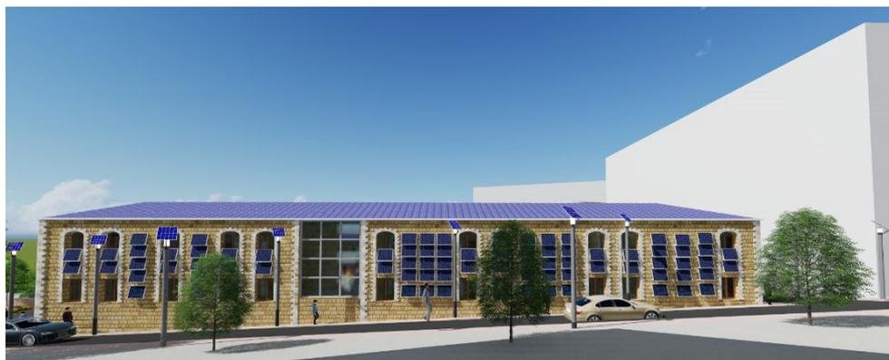
Figure 52 Intégration des panneaux photovoltaïques sur la façade Sud-Est
