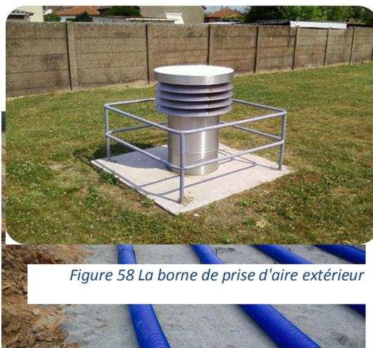
Figure 58 La borne de prise d'aire extérieur
