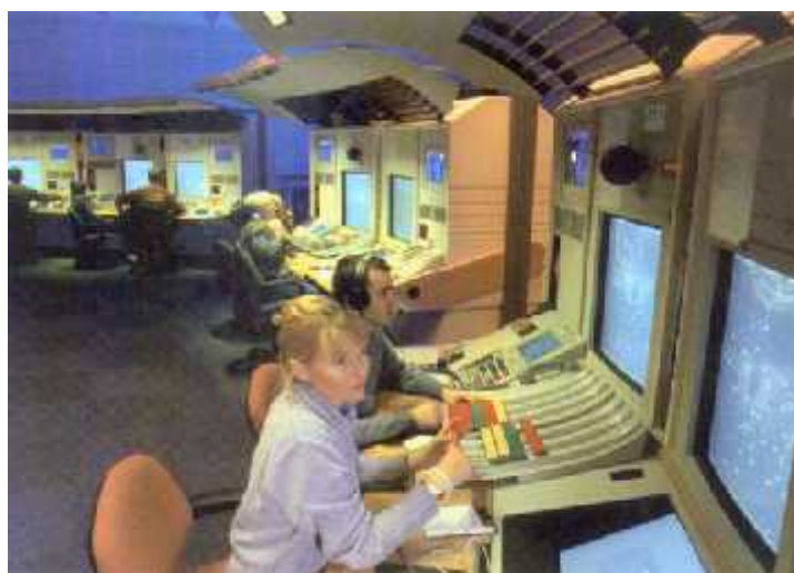
FIG.I.2 – Une salle de centre de contrôle
