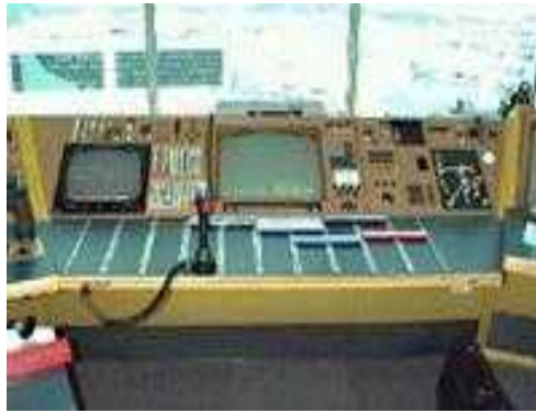
FIG.V.6 – Poste de contrôle en vigie
