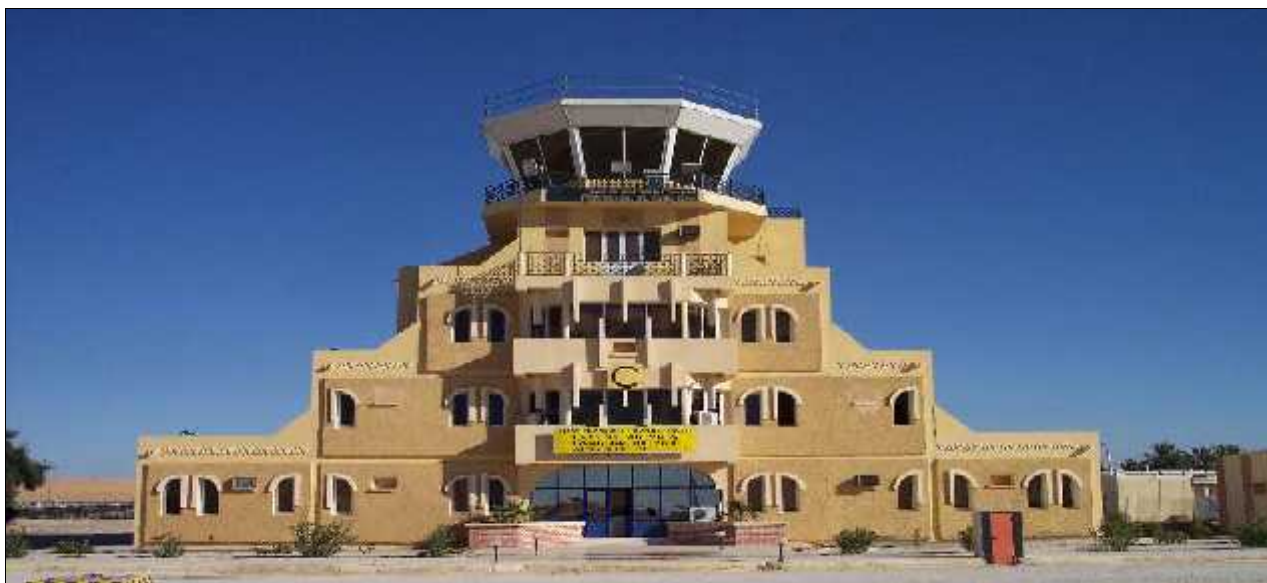
Figure 3.13 : Tour de Contrôle de Hassi Messaoud
