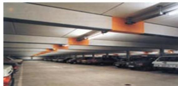
Remplissage en béton des chambres de la poutre I, Allemagne.
