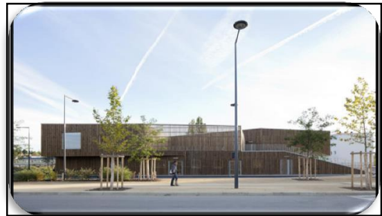
Fig. 115 Façade secondaire Source https://www.kiiwan.com/portfolio-item/pole-culturel-nevers-o-s-architectes/
