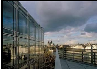
Fig 102. Terrasse au dernier niveau
