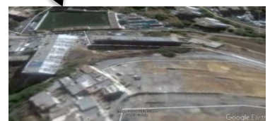
Fig.3.24 Accès num 4 . Srce. Auteurs 2017
