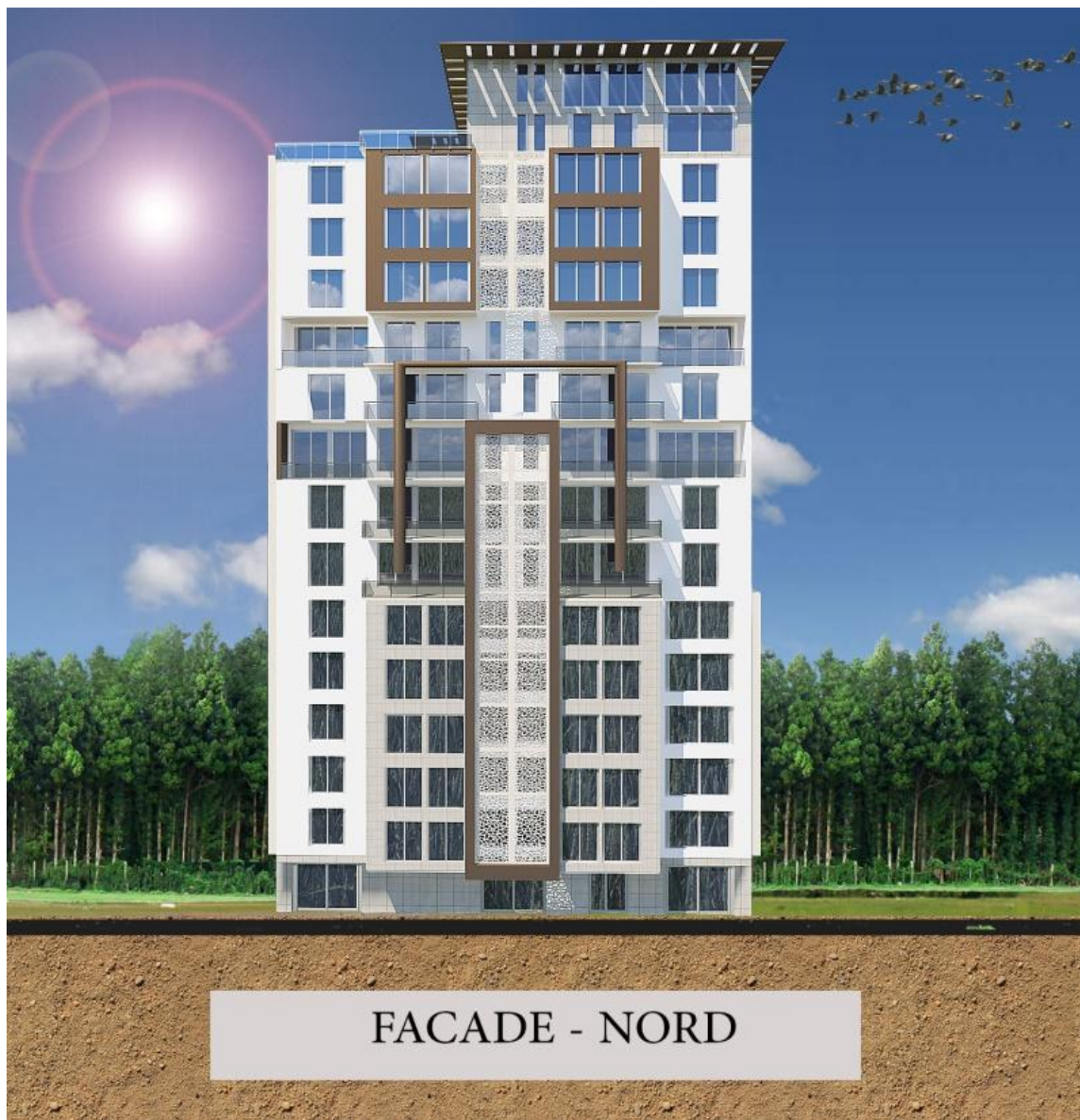
Fig.4.41 façades principale tour A et C . Srce. Auteurs 2017
