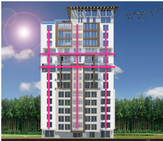
Fig.4.36 façades postérieur tour A et C . Srce. Auteurs 2017
