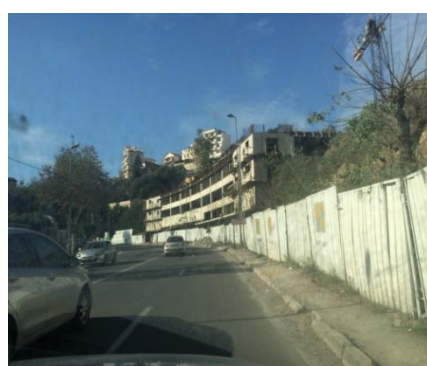
Un parking en train de réalisation (R+13)
