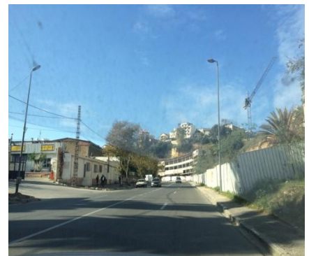
un garage de ETUSA en face de note site (R+1)
