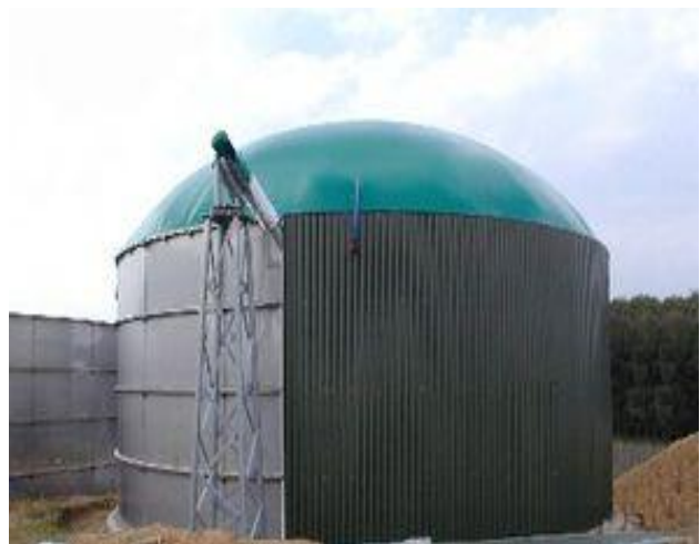
Figure I.8 : Exemple d'un digesteur construit en inox.
