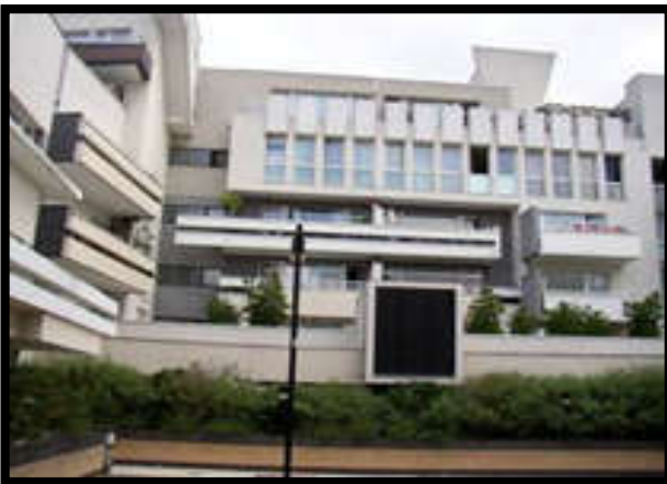
Fig.32 Façade donnant sur le cœur de l'îlot
