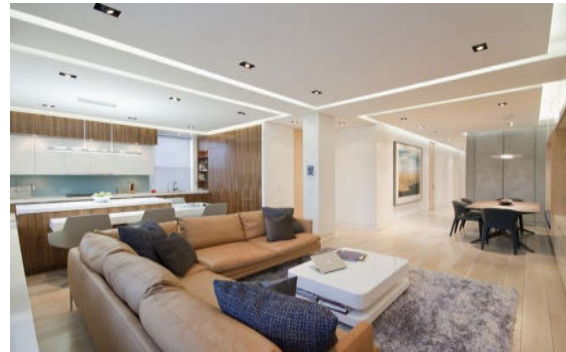
Fig. 57 salon en faux plafonds
