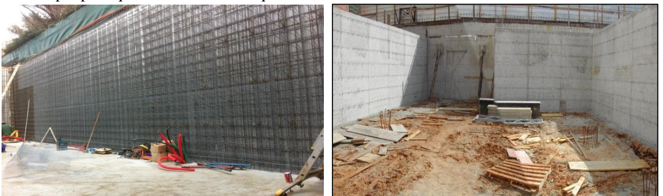
Figure 01-02: Mur de soutènement.
