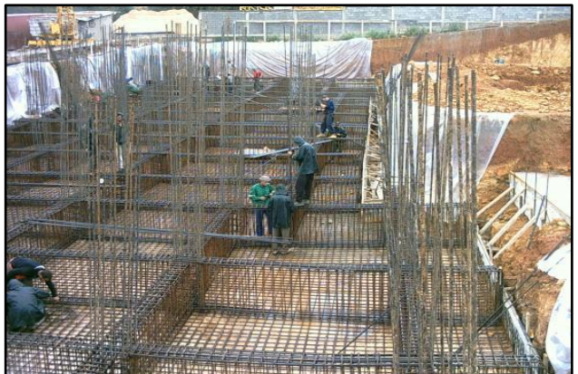
Figure 06: Fondation en radier en travaux.
