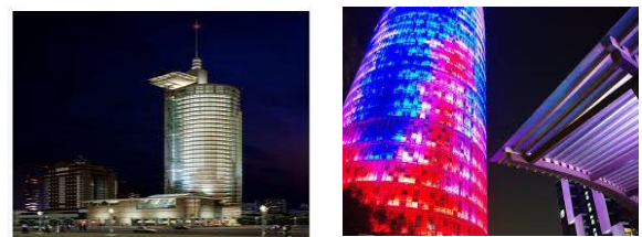
Figure n°=11: Montrant la valorisation de l'extérieur du projet par la lumière.
