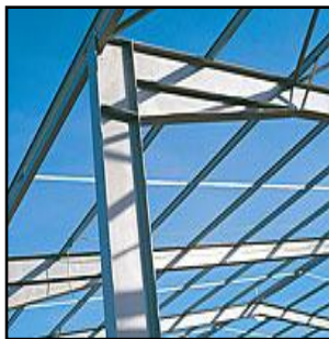
assemblage poteau/poutre et faux plafond
