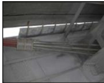
Assemblage de câble avec la poutre
