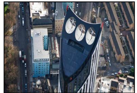
figure9-Éolienne de la tour de Strate London
