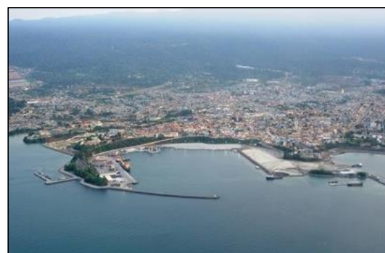
Fig (02) 02 : Exemple d'ouverture sur la mer, port de Malabo après les travaux. Src : Malabo face à la crise pétrolière, 21 déc. 2014.
