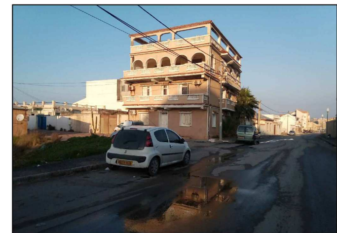
Figure : Bâtis en bonne état (Source : Auteurs 2017)
