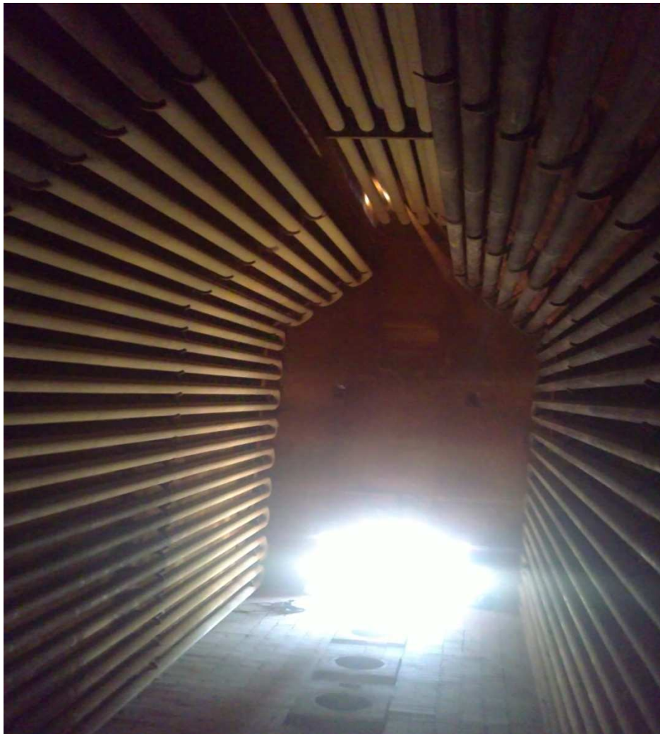
Vue de l'intérieure du four
