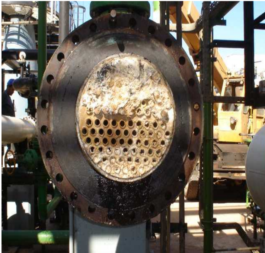
Faisceau tubulaire bouché
