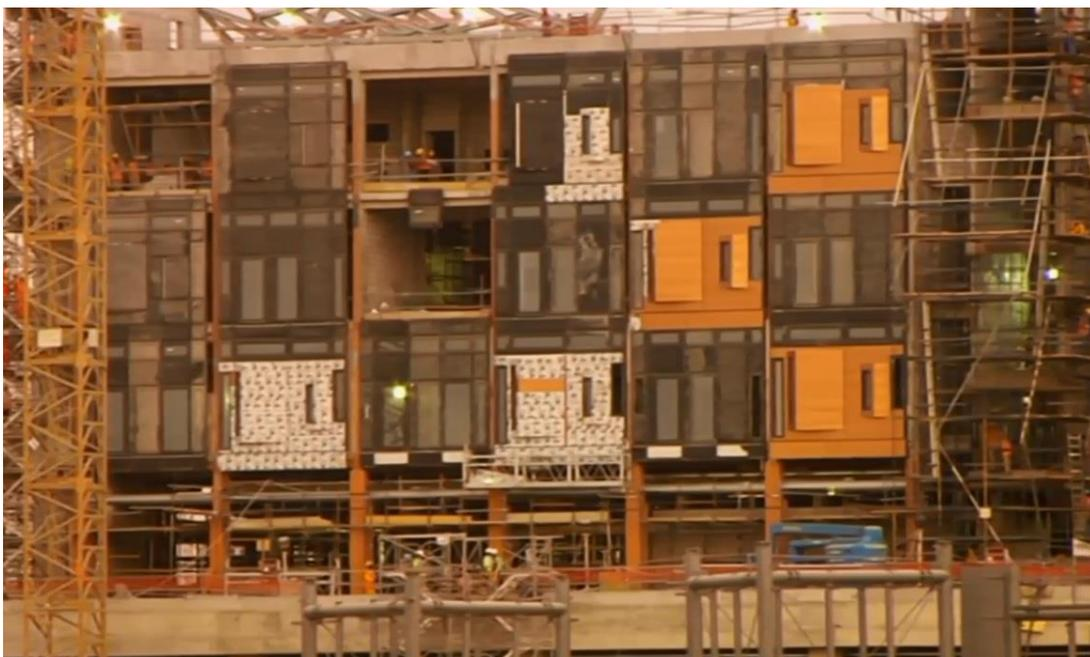
**Figure n°=21** Montrant l'installation des panneaux BRV
