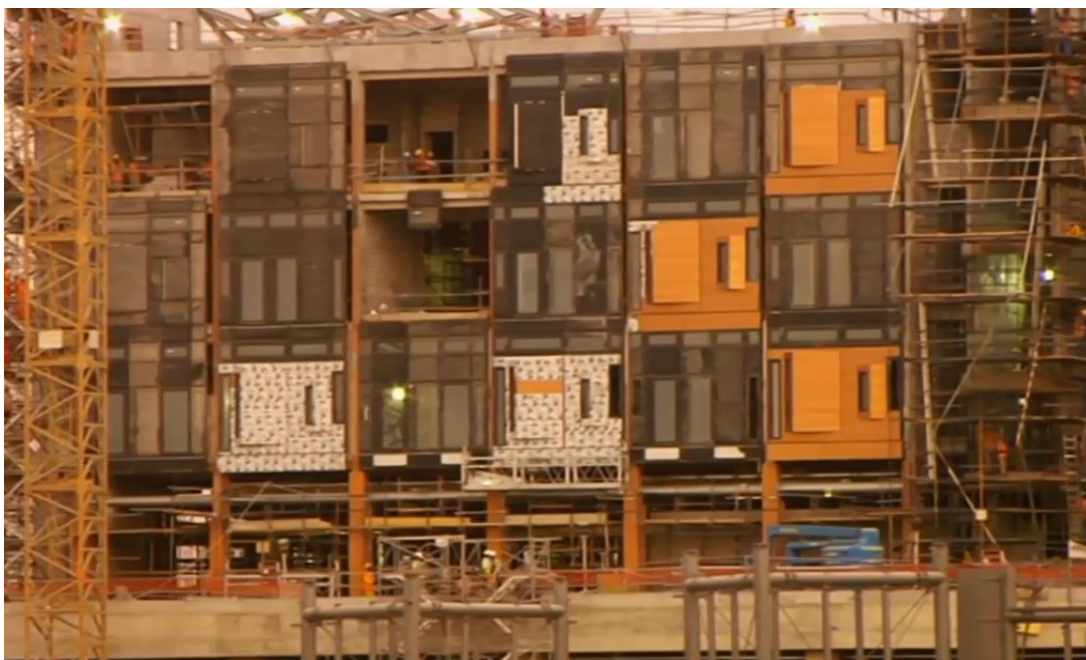
Figure n°=25 Montrant l'installation des panneaux BRV
