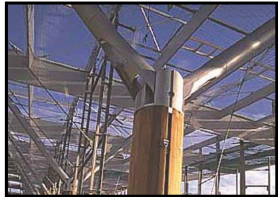
Figure n°= 06 Poteau arborescent: utilisé dans la structure de la galerie
