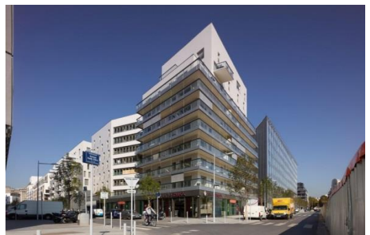
Fig 2.23 logement et commerce
