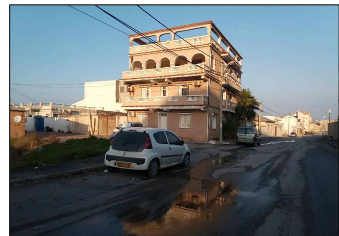
Figure : Bâtis en bonne état (Source : Auteurs 2017)
