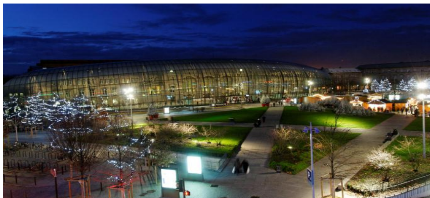
Fig.66 : Eclairage des panneaux places de la gare de Strasbourg (Source : web)
