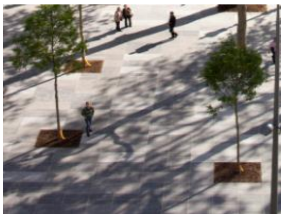
Fig.88 : Revêtement de sol place de la place de la République (Source : web)
