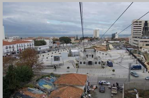
Fig.140 : place station de Métro des Fusillés (source : photos N.Z.RAHIEL)
