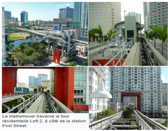
Fig. 10: Différentes vue de la station First Street Metromover, Miami (source wikimedia.org)
