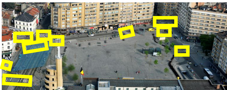
Fig.58: continuité des traversées piétonnes, place Flagey, Bruxelles (source: web)
