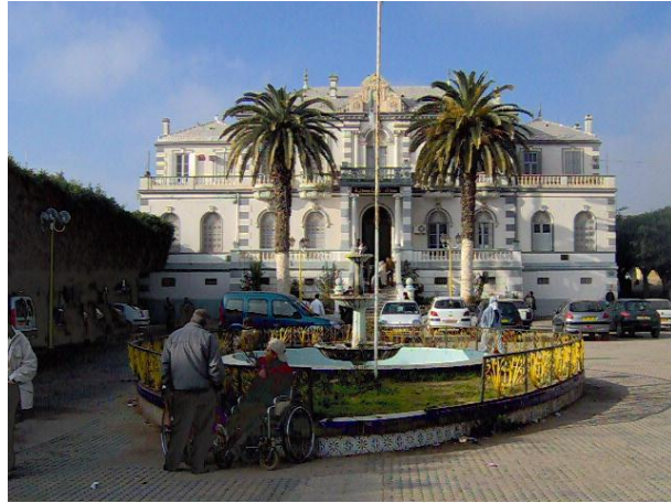
Figure 19 : Vue de La Placette de la Mairie avant le Réaménagement (présence d'une fontaine)
