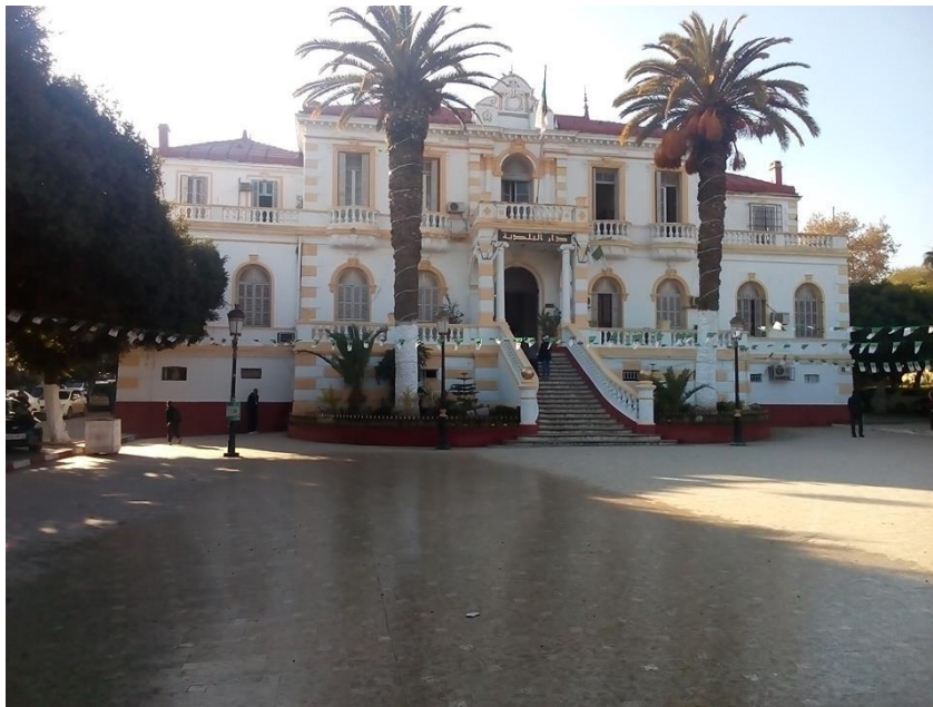
Figure 01 : La Mairie de Koléa
