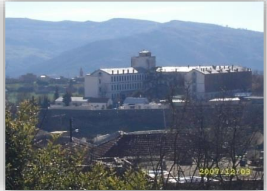
Fig.: Vue sur la caserne
