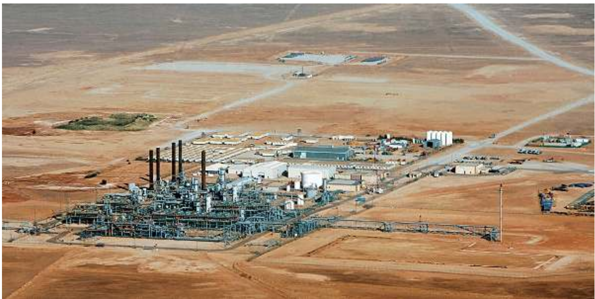
Figure 14: Le site de CSC à In-Salah
