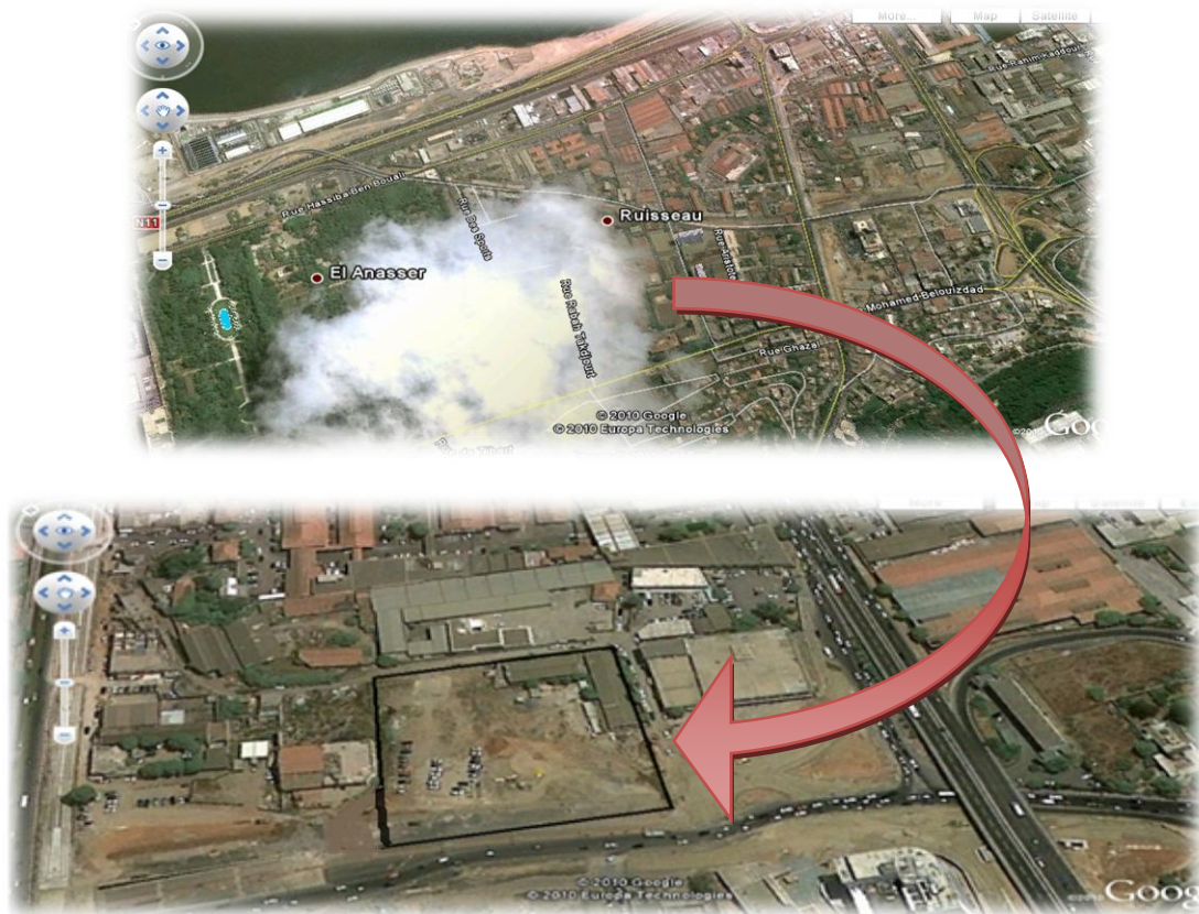
Vue aérienne du site d'intervention
