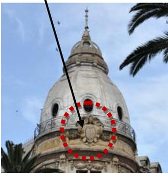
La toiture est de forme arrondie pour une esthétique séduisante et originale et permet d'occuper une plus grande partie des combles, elle comporte des lucarnes en œil de bœuf permettant plus de lumière et d'aération. Aussi la toiture est couronnée d'un élément en fer forgé.
