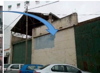
Figure 16 : Façade est de notre cas d'étude Source : Auteur
