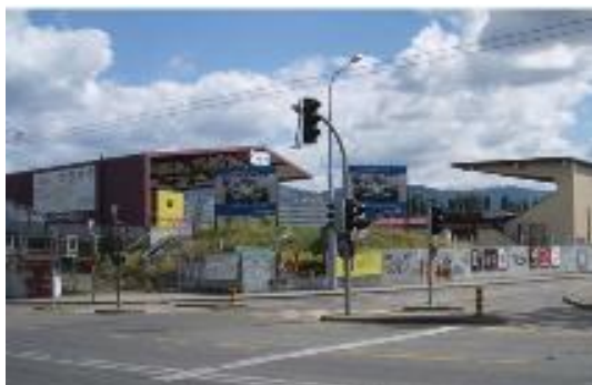
Figure 10 : Friche infrastructurelle à Genève Source : https://www.ecoparc.ch/fileadmin/user_upload/resources/Forum07_Rey.pdf
