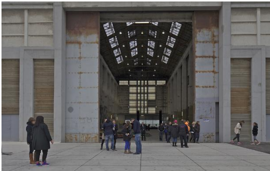
Figure 55 : L'entrée du hall AP2
