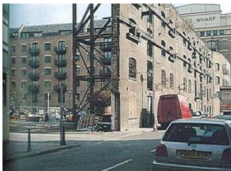
Figure 19 : « Façadisme » pour la reconversion d'un immeuble des docks en bureaux Source : http://www.ummto.dz/IMG/pdf/MEMOIRE1-3.pdf
