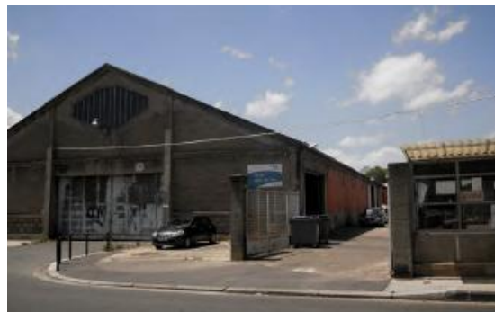
Figure 11 : Ancien dépôt de bus à bordeaux Source : Cécile Leuret https://www.archires.archi.fr/fr/node/888373
