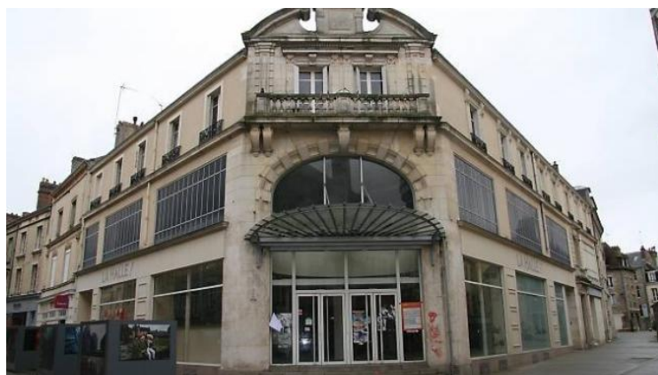
Figure 9 : Bâtiments commerciaux en friche à Alençon Source : https://www.ouest-france.fr/normandie/alencon-61000/les-friches-commerciales-seront-taxe-es-3304294
