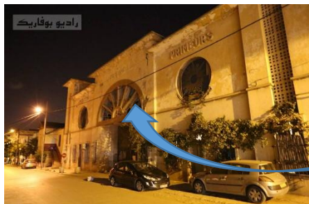
Figure 14 : Façade ouest de notre cas d'étude Source : Radio Boufarik (Facebook)
