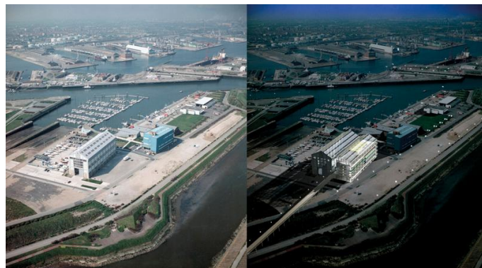
Figure 47 : bâtiment du Frac /AP2
