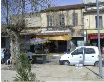
Figure 100 : Habitation semi collectif Source : Auteur
