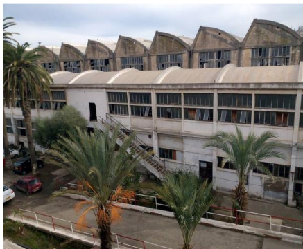
Figure 5 : Les ateliers de maintenance d'El -hamma Source : Etudiants de l'atelier
