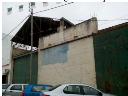
Figure 119 : Façade est du bâtiment Source : Auteur
