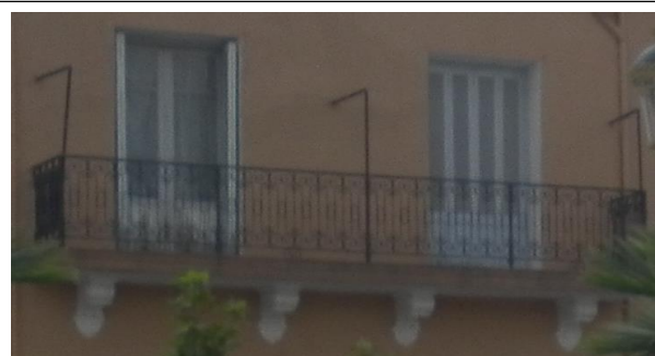
Deux ouvertures de forme rectangulaire assemblées par un balcon jumelé, on marque l'existence des consoles sous le balcon et l'absence de décoration
