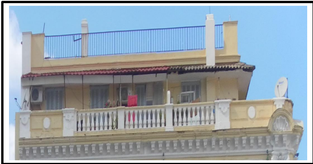
Figure n°4,16 : un toit terrasse.
