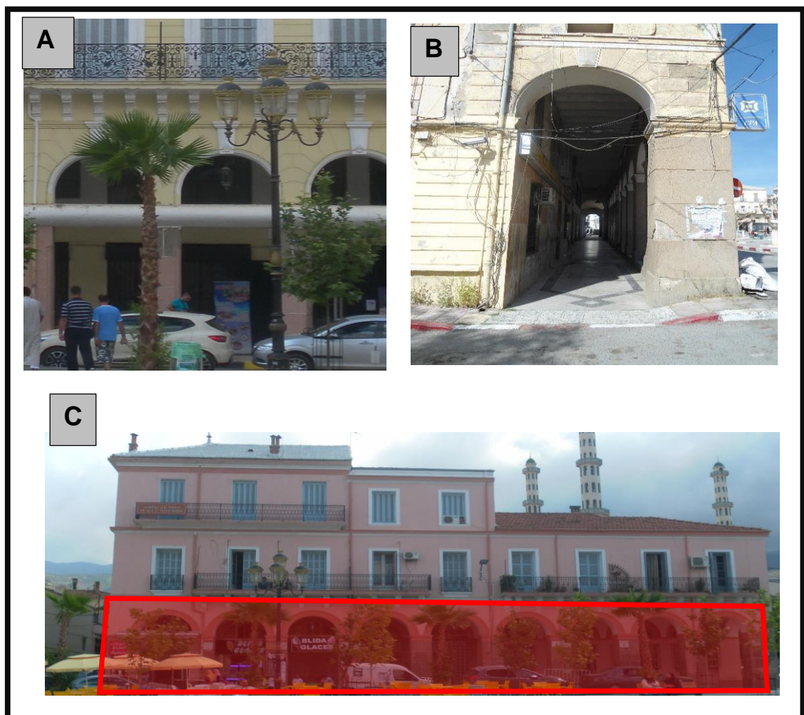
Figure n°4,10 : vue sur le soubassement de la paroi de la place, A/ façade B1, B/ une galerie d'arcade, C/ façade A2.
