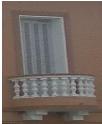
Une simple ouverture de forme rectangulaire encadrée avec balcon en demi cylindre (courbé) maçonné avec des éléments et porté par des consoles à moulure.
