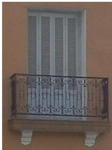
Une simple ouverture de forme rectangulaire avec balcon de fer forgé on marque l'existence des consoles sous le balcon
