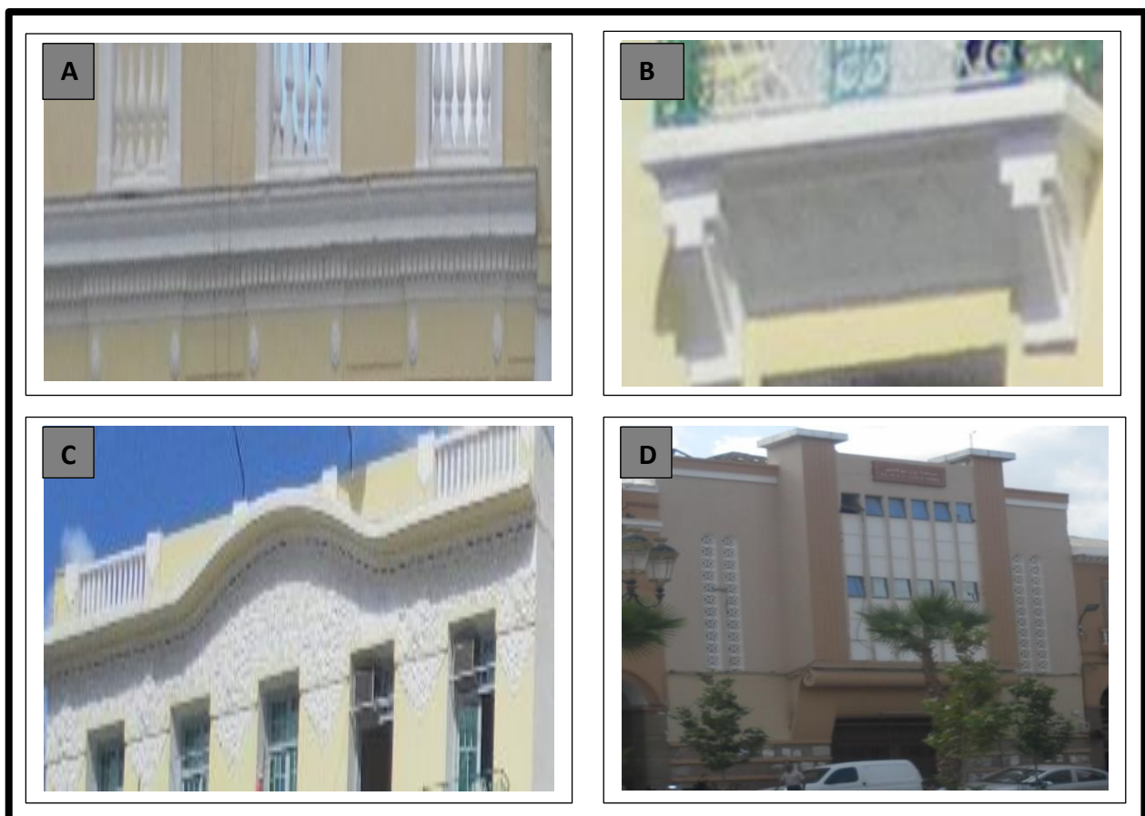
Figure n°4,21 : les éléments architectoniques./A : le listel /B : le talon /C : l'ornement / D :
