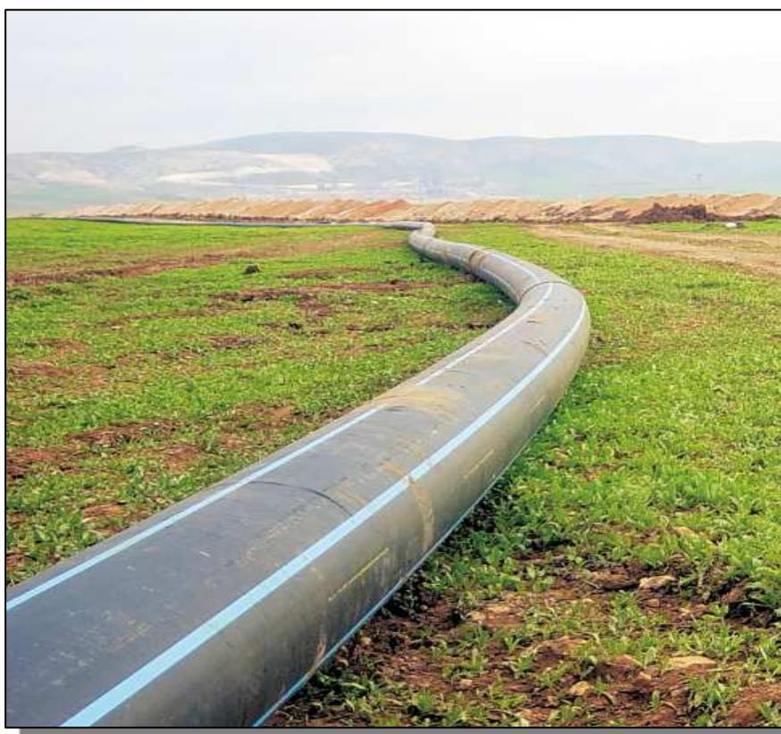
**Figure II.7: Tube PEHD pour distribution d'eau potable**
