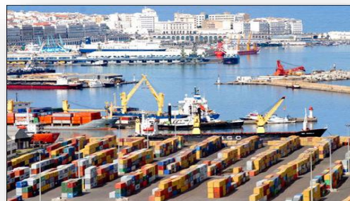
Fig. N°25: le Port industriel d'Alger
