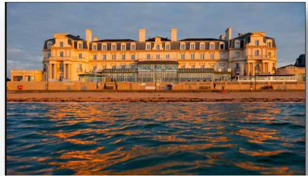
Hôtel saint Malo orienté vers la mer pour profiter de la vue. Source: morethanblond.ch/thalasso-der-bretagne
