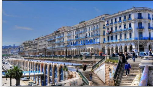
Fig. N°32 : Le front de mer de la ville d'Alger
