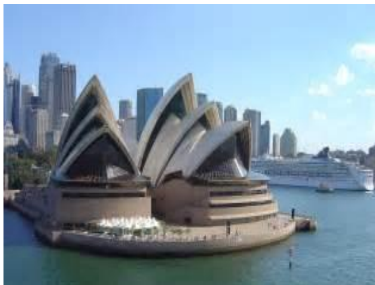
Figure 07 : Opéra de Sydney(Australie). Les grandes ouvertures pour L'éclairage naturel et la ventilation (source : coolwallpapers.org)
