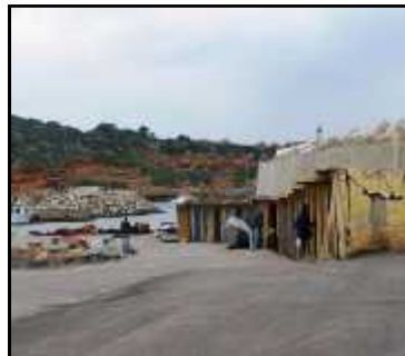
Figure 54: Lieux de stockage
