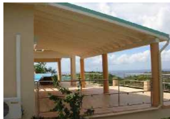
Figure28 : Terrasse couverte pour se protéger De l'ensoleillement
