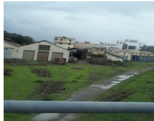
Figure 42: SNTF Blida, photo prise par hauteur
