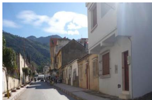
Figure 56: Bâti en bon état photos prise par l'hauteur
