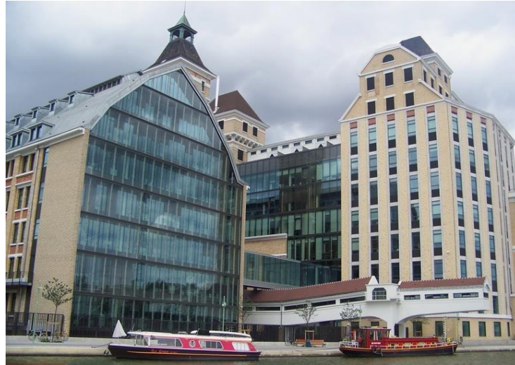
Figure 19: Vue sur l'enveloppe extérieure, source: www.google.com
