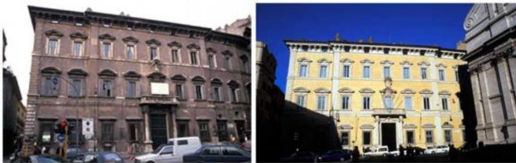
Figure 4: Palais Altemps avant et après la restauration, Rome source: www.google.com
