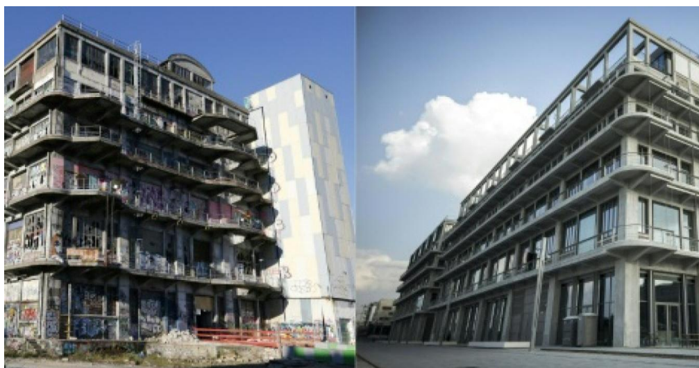
Figure 6: la reconversion des anciens magasins généraux de pantin Source: www.google.com
