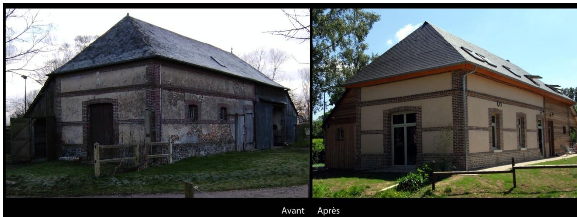
Figure 2: Réhabilitation d'un bâtiment industriel.
