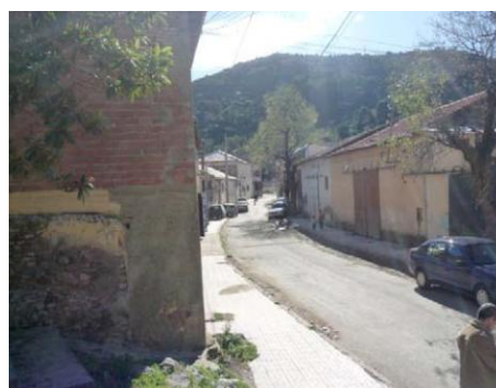
Figure 58 : Habitat en moyen état source : hauteur
