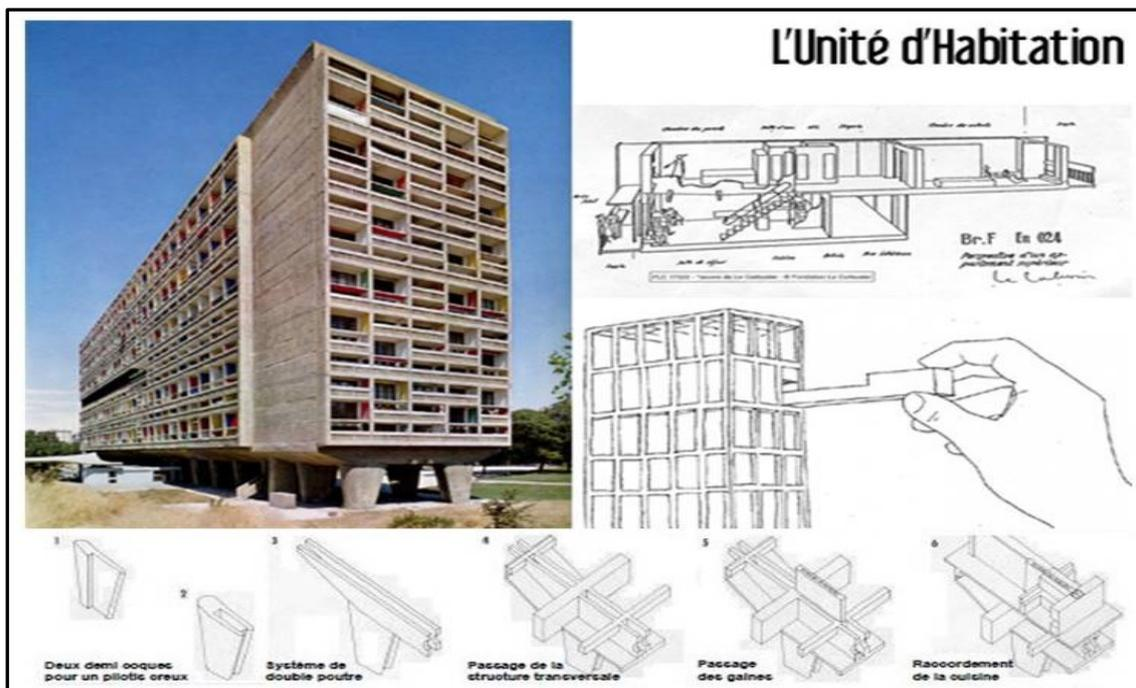
Figure 64. La cité radieuse de Marseille, et le principe de la bouteille.
