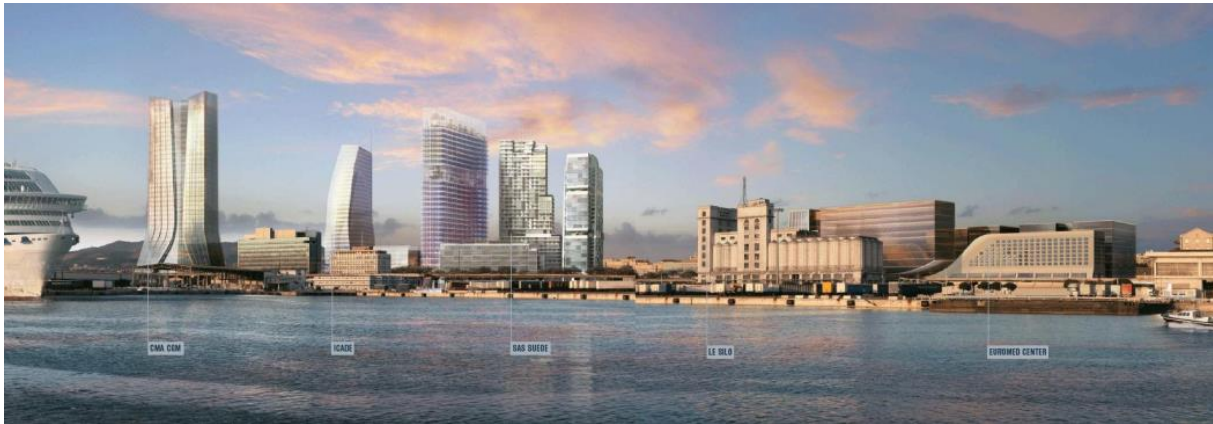
Figure 57: Nouvelle façade maritime de Marseille suite au projet Euro-méditerranée. Source : projets-architecte-urbanisme.fr
