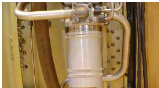
(Fig.II-2-3-6) le filtre de récupération.
