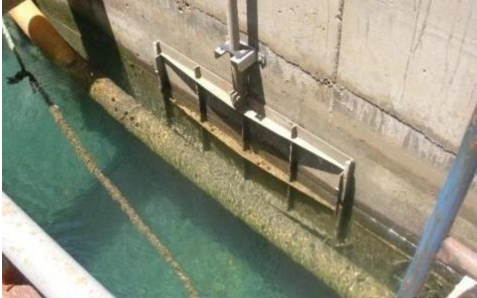
Photo 09 : Trappe permettant le réglage du débit d'eau.
