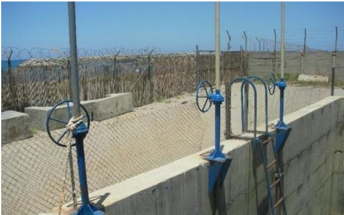
Photo 09 : Trappe permettant le réglage du débit d'eau.
