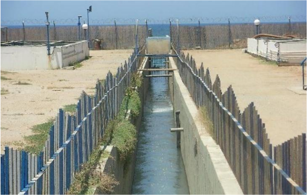
Photo 13 : Le canal de rejet
