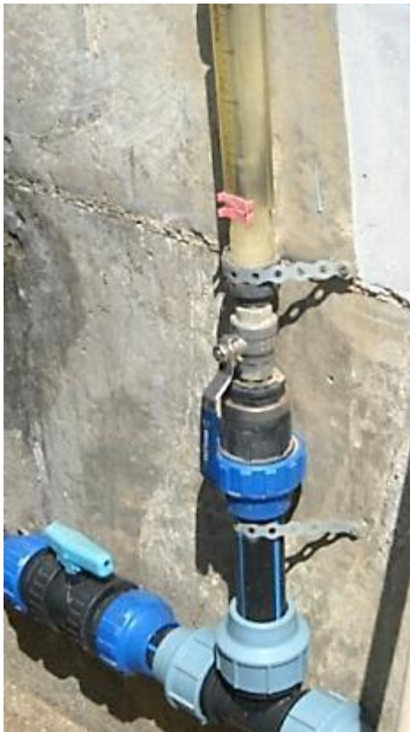
Photo 8 : Vanne de réglage de débit d'oxygène.
