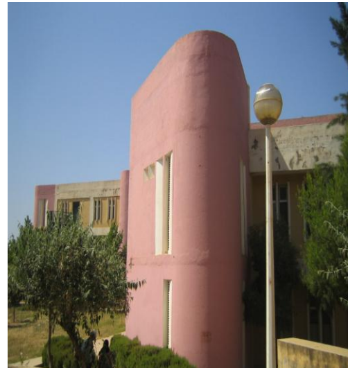
Figure 4 .2 : Face Sud du pavillon N°13
