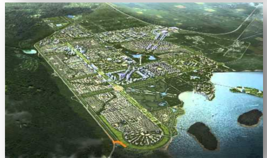
Fig 8. Ville Nouvelle de Boughezoul
