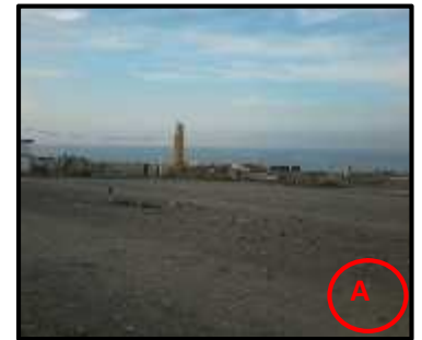
Figure 3-26 :vue sur la protection: /Source : Auteur
