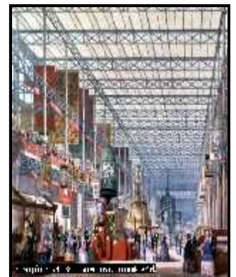
Figure 3-67 : la structure métallique
