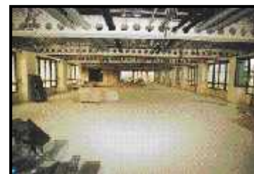
Figure 3-96 : Passage des gaines par les alvéoles.
