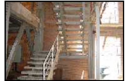
Figure 3-84: les escaliers métalliques.
