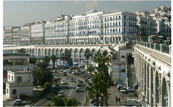
Figure11 ; balcons dans la rue che guevara alger
