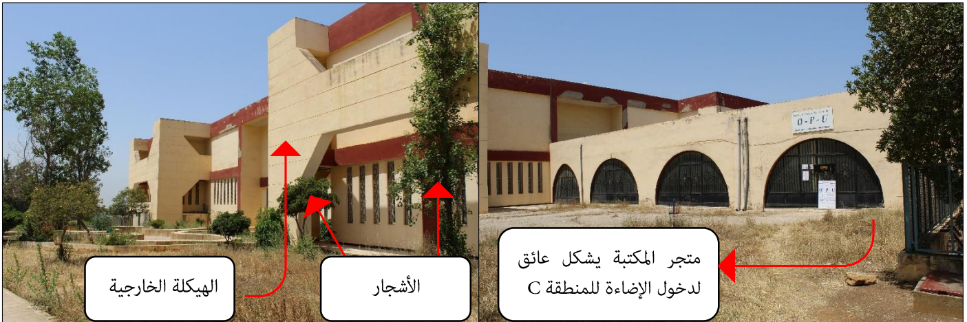
لوحة 3.2: صور من أرض الواقع توضح العوائق المحيطة بمبنى المكتبة المركزية-قسم العلوم والتكنولوجيا/مصدر الصور: تم التقاط الصور من قبل الكاتب
