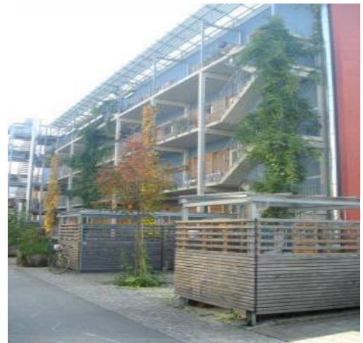
Figure 14: composteur collectif, Quartier Vauban, Fribourg
