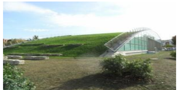
Figure 12: toiture végétalisée sur bâtiment annexe ,quartier Rieselfeld , Fribourg( source:
