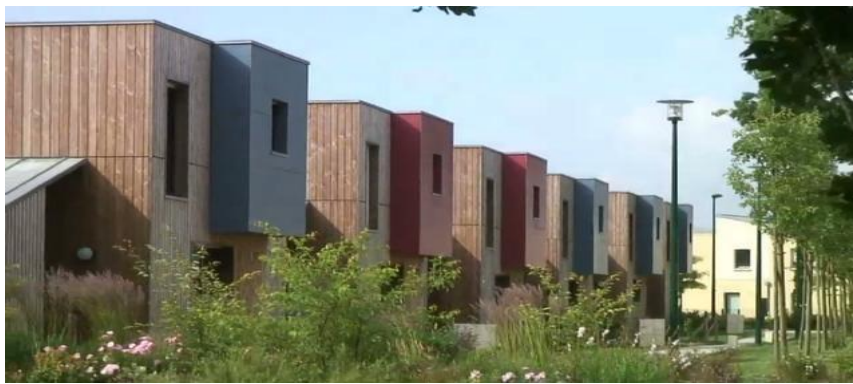
Figure 7: Les maisons Memphis 'Maisons Mitoyennes, Vern-sur-Seiche
