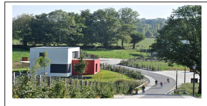
Figure 21: Voirie desservant le lotissement (source: 85-LES HERBIERS Val de la pellinière.pdf)
