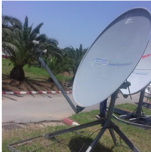
FigureIV.2 : Antenne 2.4m assemblée et monté en émission-réception
