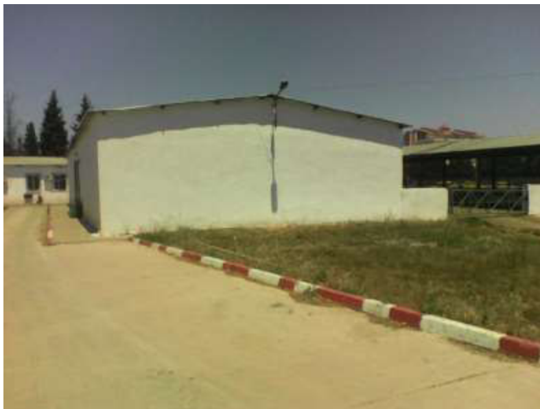
- - Photo 1: station de baba-Ali (logement des veaux)
