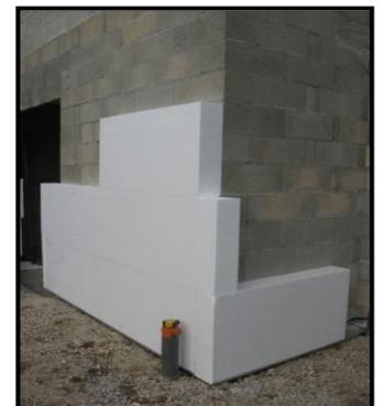
**Figure 51 :** Polystyrène expansé
