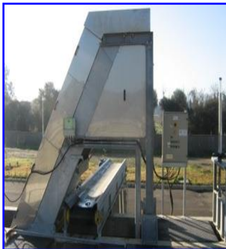
Figure 29 : Dégrilleur grossier
