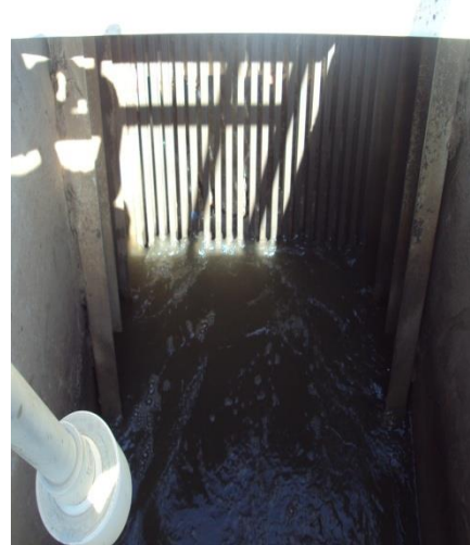
Figure 30 : Dégrilleur
