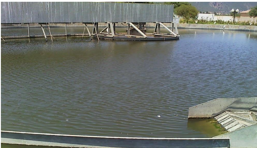
Figure 34 : Clarificateur
