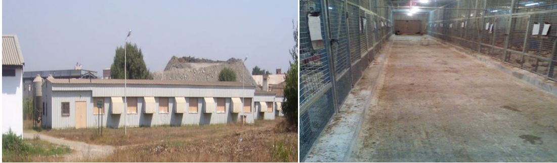
Figure 6 :vues (extérieure et intérieure) du bâtiment Témoin.
