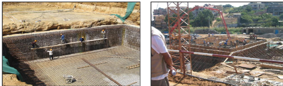
Figure 2.1 : Vues montrant les travaux lors de la construction [1]
