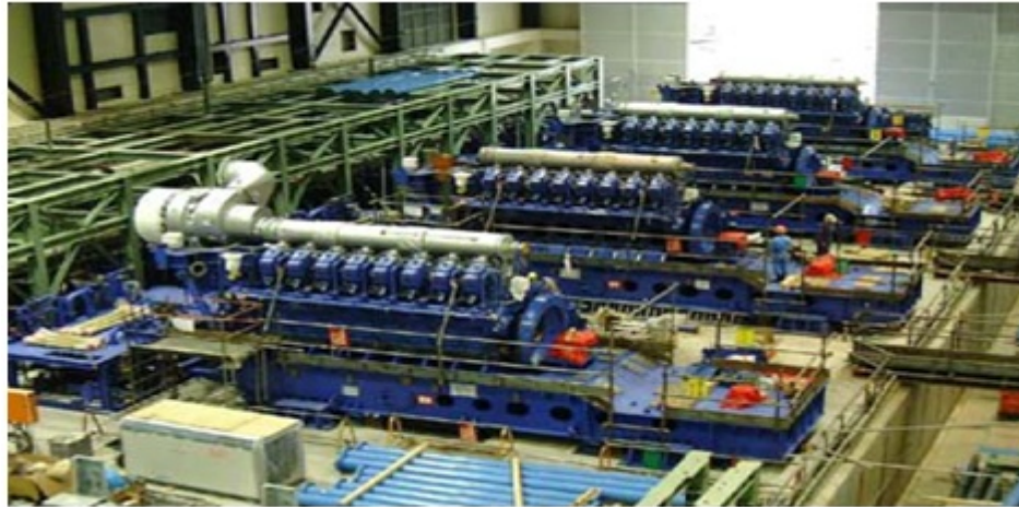
Figure 1.5 : Centrale hydraulique d'une la table vibrante au Japon [30]
