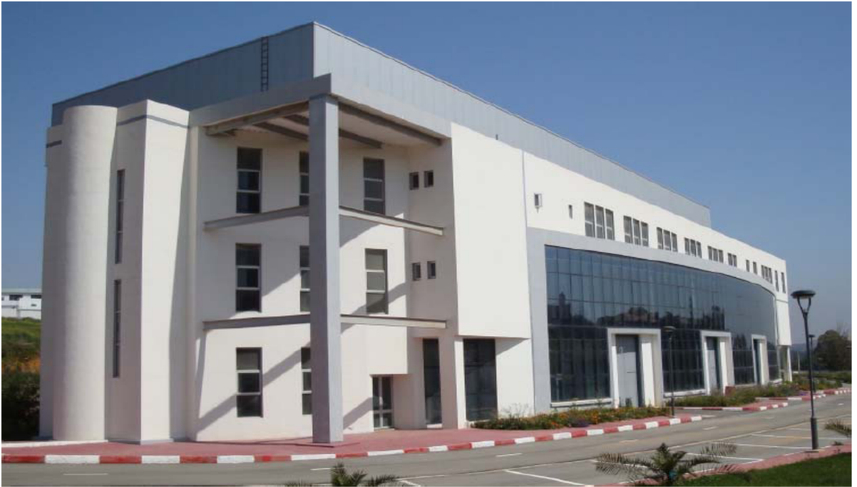
Figure 2.2 : Vue globale du laboratoire après l'achèvement des travaux
