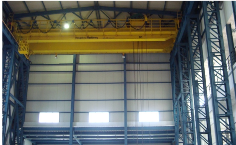
Figure 2.11 : Vue sur le pont roulant du laboratoire du CGS
