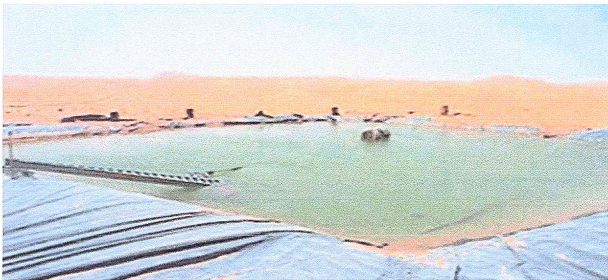
Figure (II-7) : fosse servant de réservoir d'eau.
