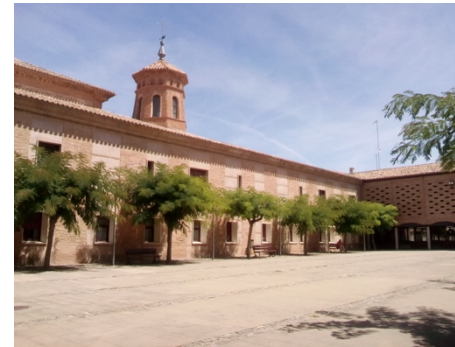
Fig.8 : Cour intérieur dans une maison de retraite.
