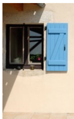
Fig.6 : Fenêtre dans façade.
