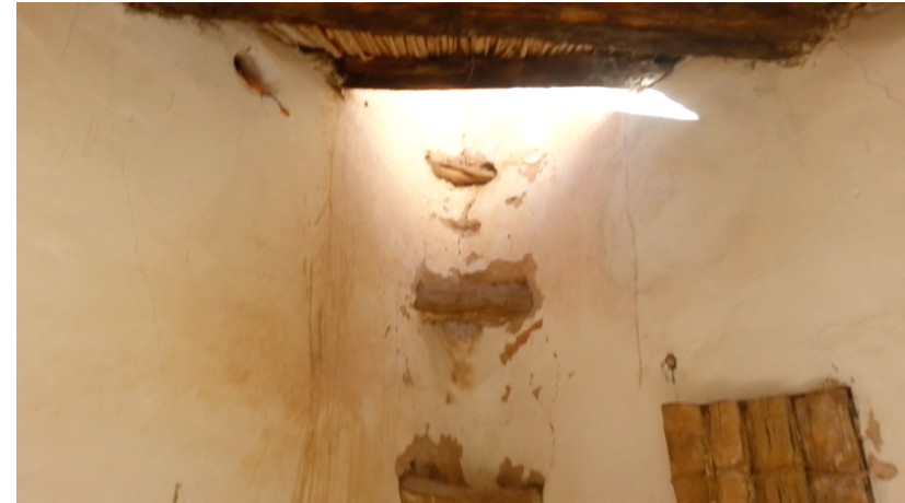
Fig.82 : Accès à la terrasse dans l'Ihenen 6.
