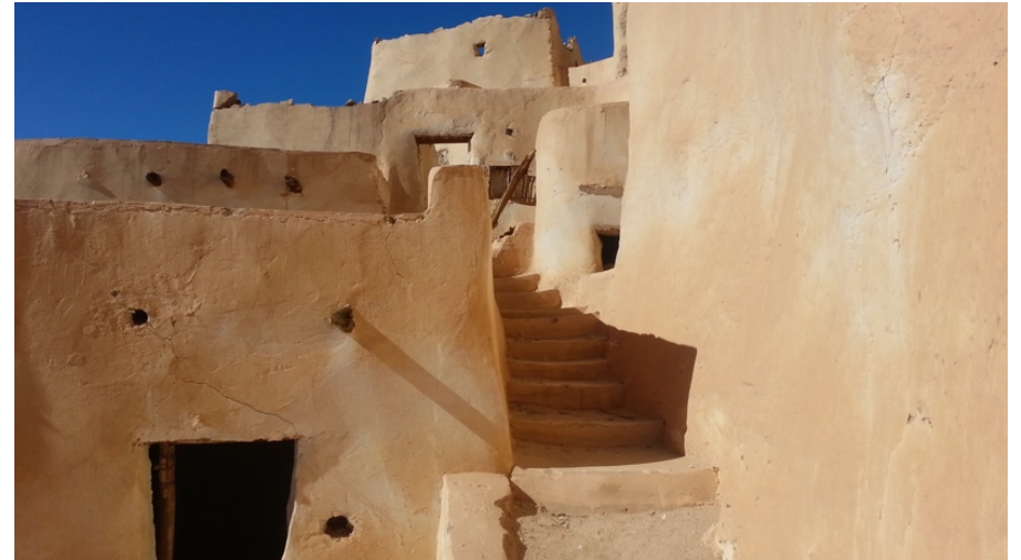
Fig.67 : Accès à la terrasse dans l'Ihenen 3.
