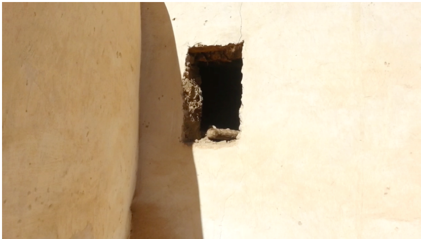
Fig.60 : Ouverture dans le mur de l'Ihenen 2.
