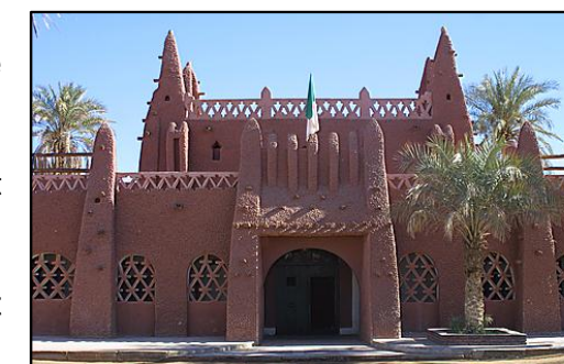
Figure 29 Façade principale de l'oasis rouge
