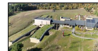
Figure 48 Quatre panneaux solaires installés sur le toit
