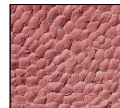
Figure 38 Enduit en méthode tboulit
