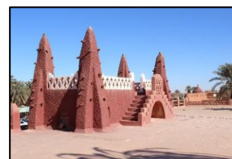
Figure 34 Escalier de l'oasis rouge
