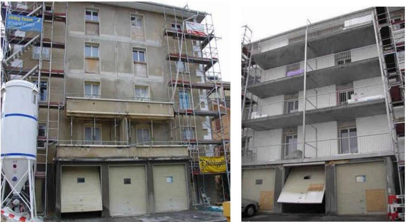
Fig II-31 .Remplacement des balcons
