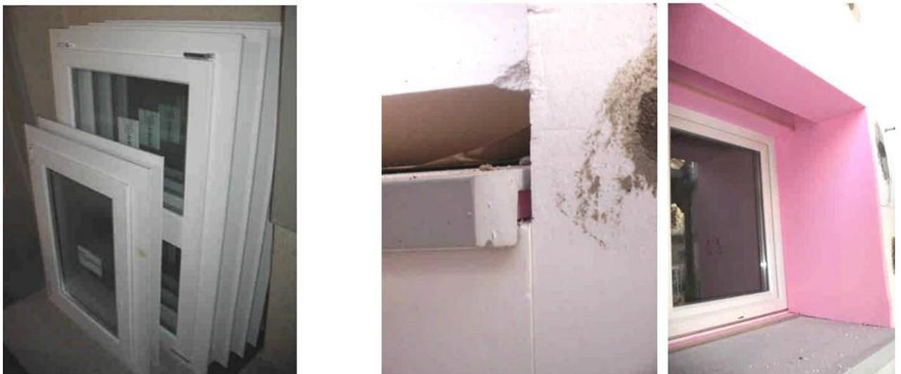
**Fig II-30** .Changement des fenêtres avec cadre PVC.  $U_f = 1,5 \text{ W/m}^2\text{K}$ . Isolation des embrasures et tablettes.
