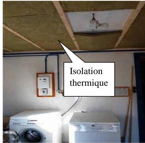
**Fig II-33** .Isolation sous dalle sous-sol. Caves, corridors, buanderie, local à vélos, chaufferie garages.
