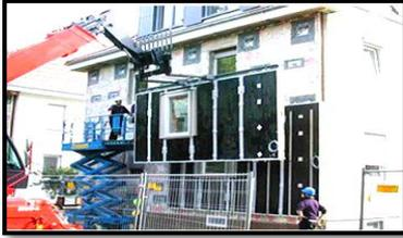
**Fig II-12.** Pose d'un parement isolant lors de travaux de réhabilitation d'un immeuble à Hofheim en Allemagne
